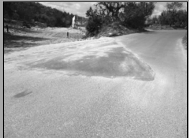
Obres de millora a l'encreuament del Barranc del Riu Sec amb el Camí del Terrer Roig
