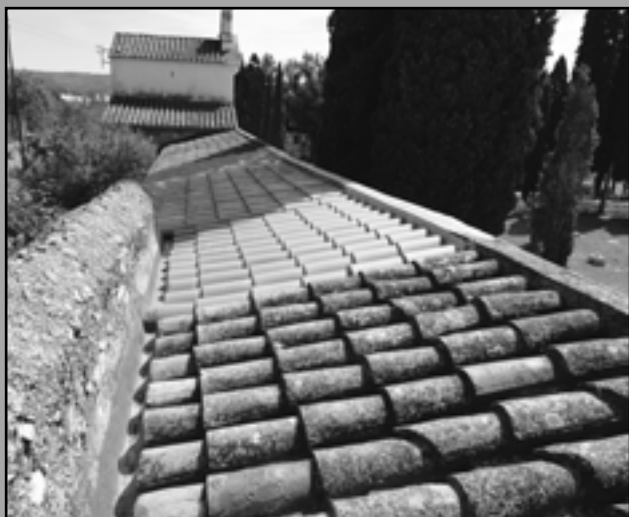
Arranjament de la coberta de la part antiga del Cementiri
