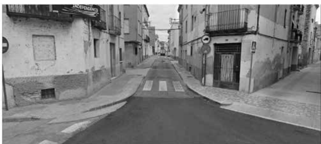
C/ de la sèquia. Interceptor núm. 3
